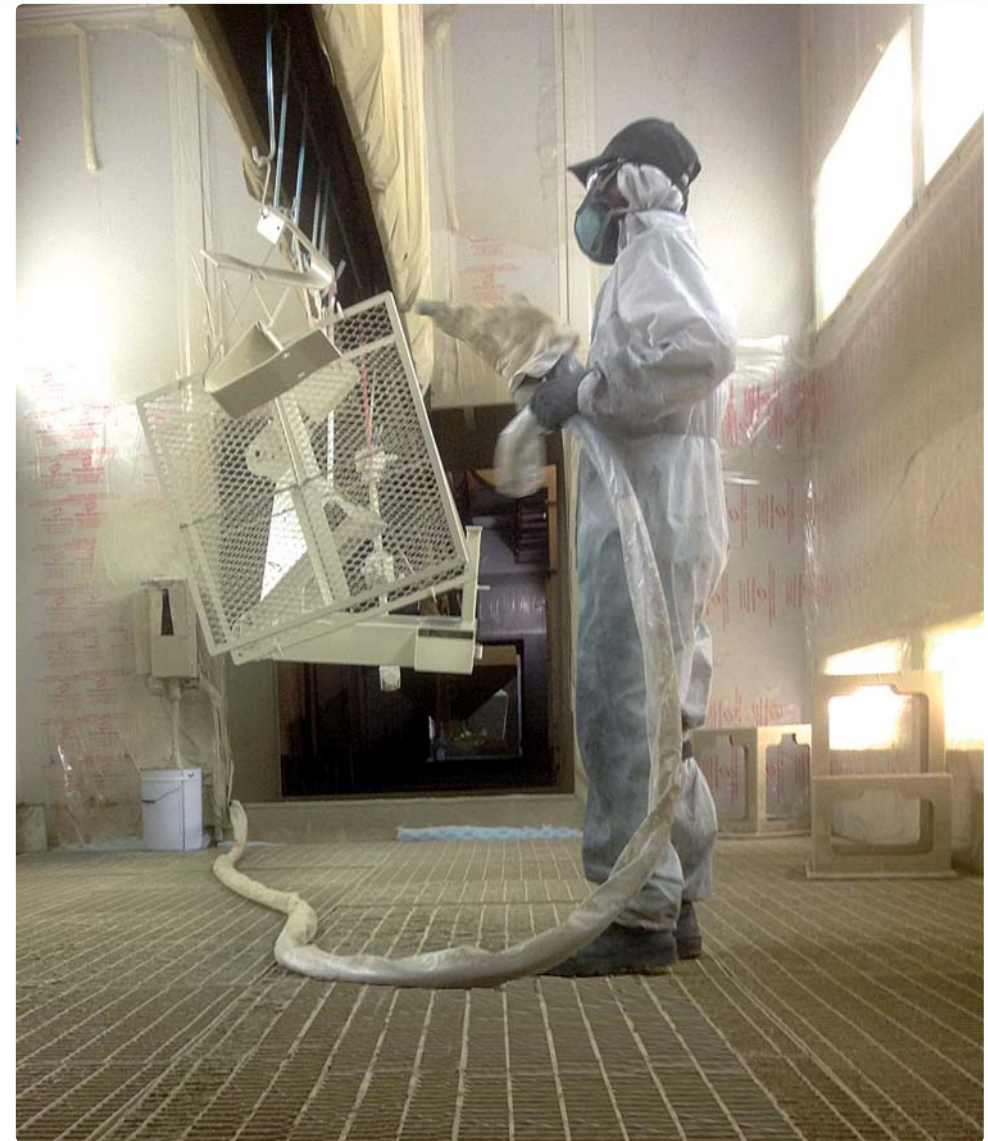
Zweite Rostschutzgrundierung und Endlack
