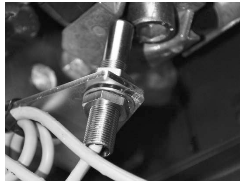
Sensor Drehzahlabnahme unterhalb der Maschine
